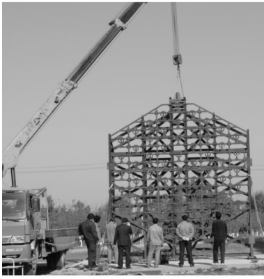
图5 支撑桁架组装后整体吊装
