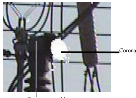
图 5(b) 高压线端子上的电晕信号
